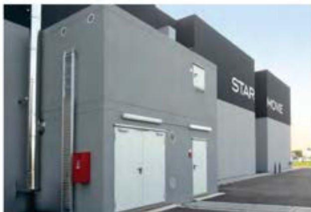
Dubbelgolvvärmemodul 200kW flis, företag
