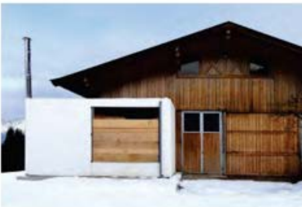
Enkel golvvärmemodul 35kW flis, gård
