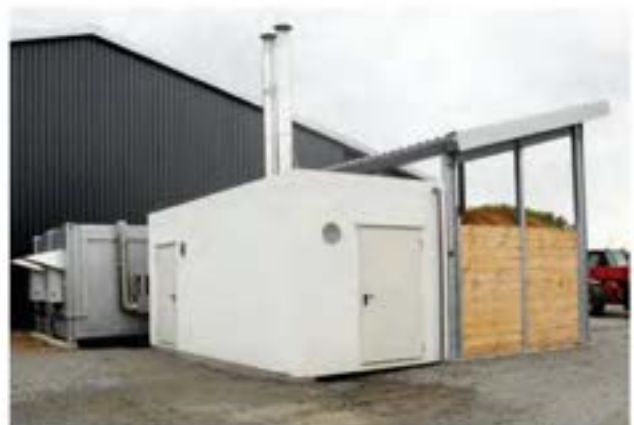
Enkel golvvärmemodul 2 x 100kW flis, företag
